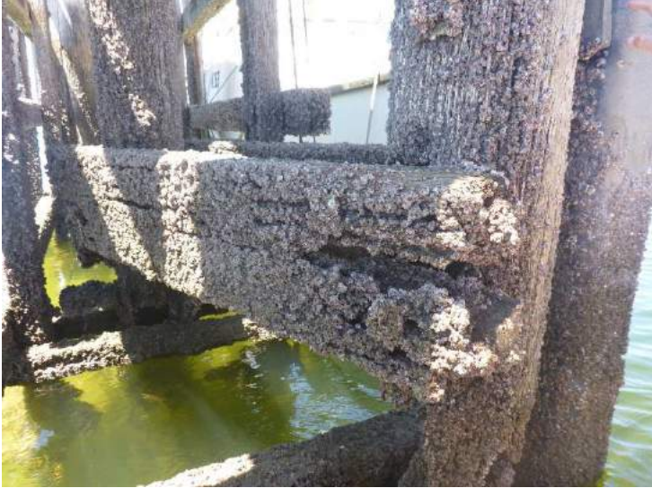
Photo 37 - Bent O12 (End)
