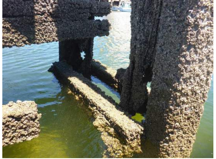
Photo 36 - Bent O12 (End)
